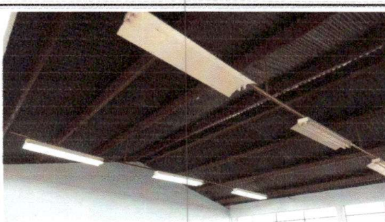
Foto 6: reparacion del sistema eléctrico
