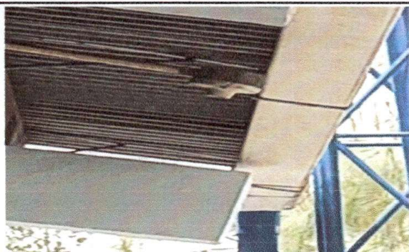
Foto 3: Sustitucion de canal de metal
