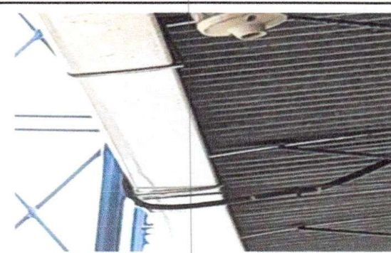
Foto 4: sustitucion de soporte o pescante de metal para canal
