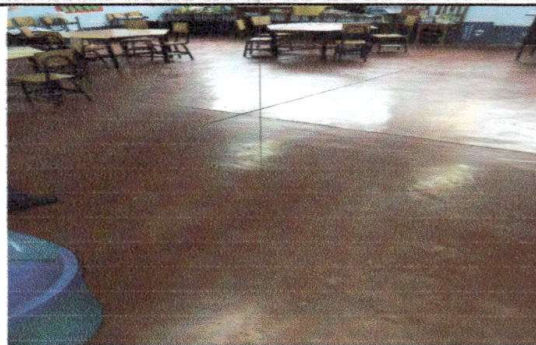
Foto 2:Sustitucion de piso de torta de concreto por piso ceramico
